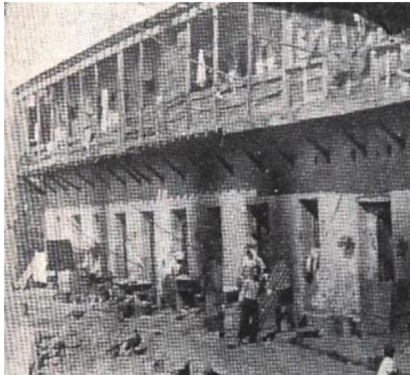
Fig.1. Conventillo N°1, construcción de dos pisos compuesta de cuartos redondos sin patio y con salida a la calle.
