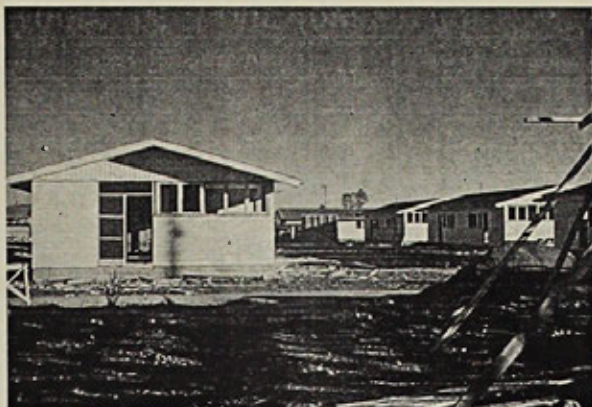
La ejecución directa en provincias ha actuado, en muchos casos, como activador económico y social de zonas tradicionalmente postergadas. En la foto, la población "Ampliación Mante Verde", construida por administración directa de la Delegación Corvi en Temuco. Consta de 80 viviendas tipo 197 SM de 48 m 2 . Se construyó en 6 meses (Febrero a Julio 1971) con prefabricación parcial, en madera, a un costo de E o 933,46 por m 2 .
